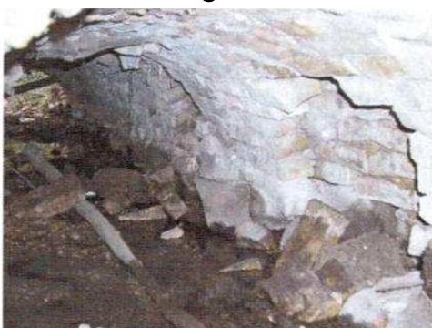
GEWÖLBEMAUERWERK ZERFÄLLT
