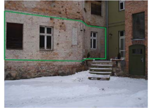
Herrenwohnung im Nebengebäude von Süden
