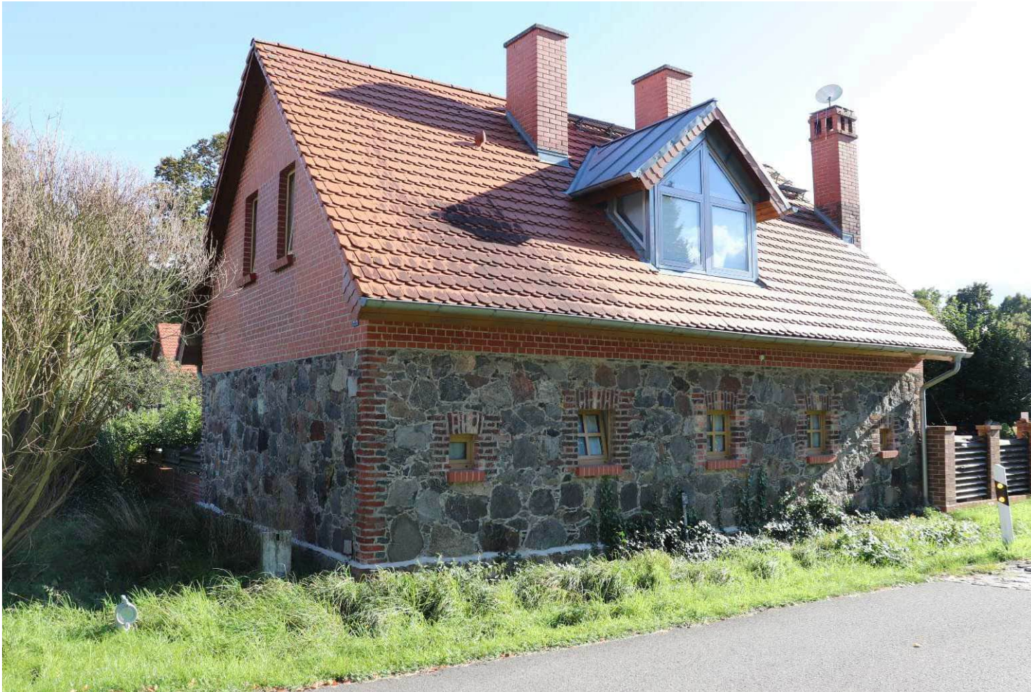
Sauen Umnutzung eines Stallgebäudes
